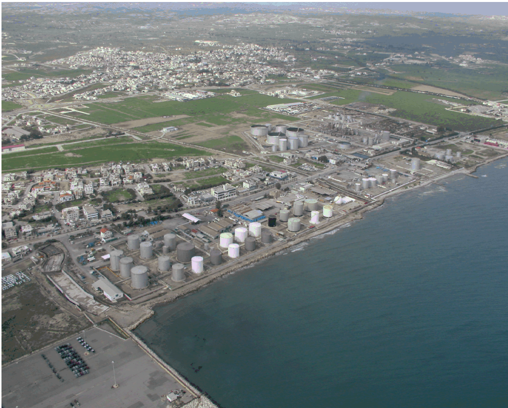
Εικόνα 3.7-1 Κυπριακό Διυλιστήριο Πετρελαίου Λτδ και Αποθηκευτικοί Χώροι Εταιρειών Εμπορίας Πετρελαιοειδών [21]
